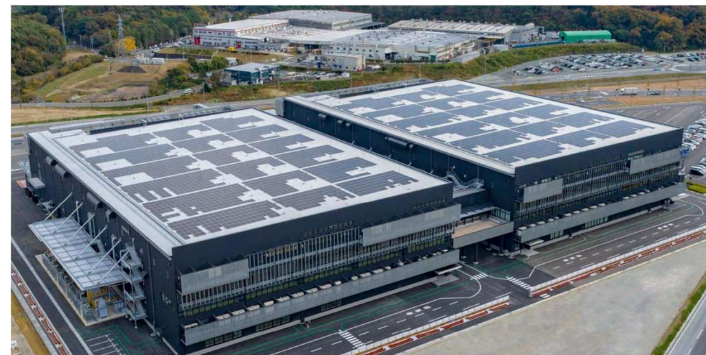
写真1. 新居工場 太陽光パネルの設置状況
